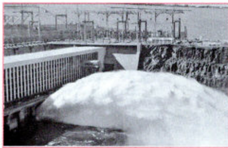
Дамба – сооружение на реке
