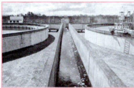
Очистные сооружения на канале
