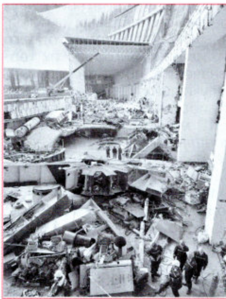
Авария на электростанции
