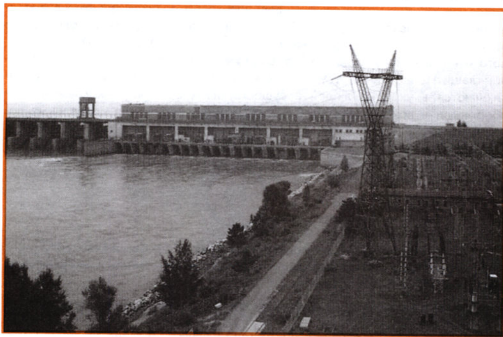
Гидротехнические сооружения: (вверху слева направо) дамба, очистные сооружения, (внизу) гидроэлектростанция
