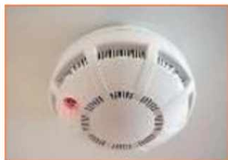
Рис. 4.7. Блок датчиков пожарной сигнализации
