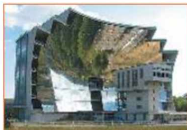
Рис. 5.10. Самая большая в мире солнечная печь для плавки металлов
