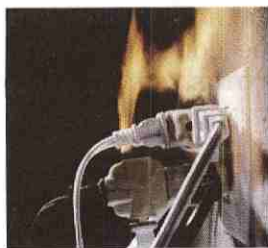
Рис. 89. Короткое замыкание в электропроводке
