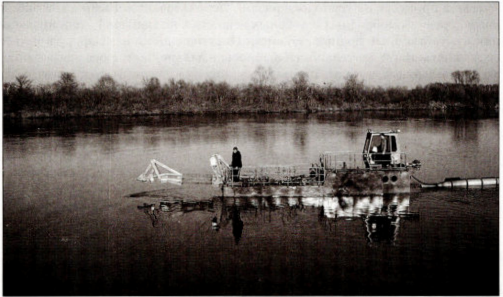
Рис. 40. Очистка водоёма от иловых отложений
