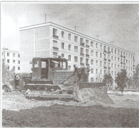
Строительство крупнопанельных жилых домов на западе Москвы. 1960 г.
