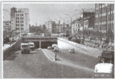
Тоннель на Добрынинской (ныне Серпуховская) пл. Москва. 1967 г.
