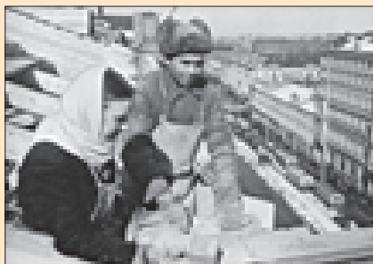
Рабочие на строительстве жилого дома. Москва. 1949 г.
