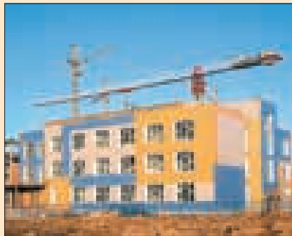
Строительство новой школы. Химки. 2013 г.
