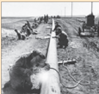
Строительство газопровода Саратов — Москва
