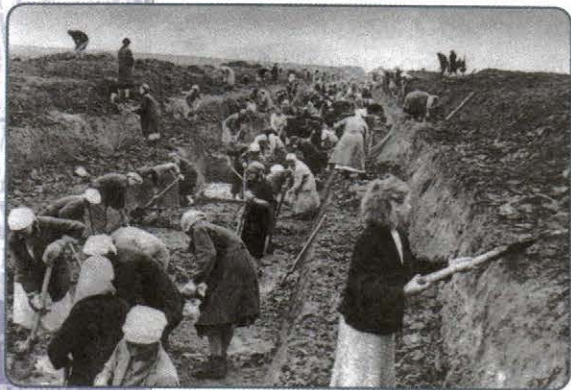
Москвичи на строительстве оборонительных сооружений. 1941 г.
