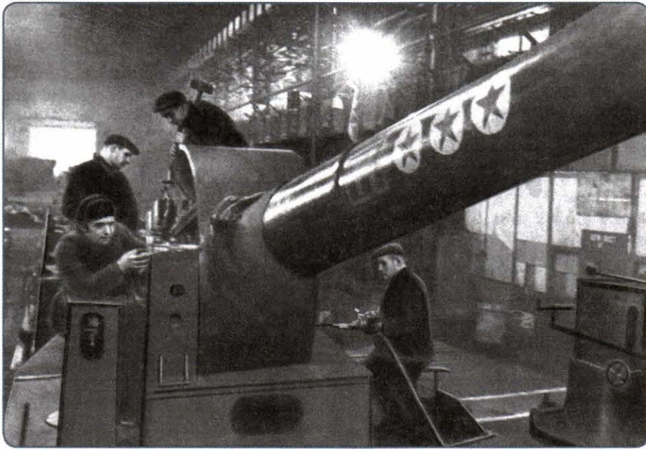
Ремонт на заводе артиллерийской установки. 1942 г.
