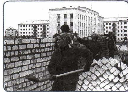
На стройке. Начало 1960-х гг.
