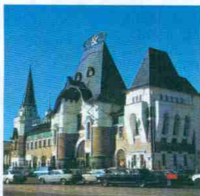
Ф. О. Шехтель. Здание Ярославского вокзала. 1903 г. Москва
