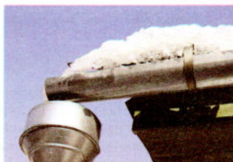
Рис. 35. Железные трубы, покрытые слоем более активного металла — цинка (при электрохимической коррозии окисляться будет цинк)
