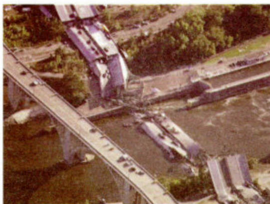
Рис. 31. Разрушение моста через реку Миссисипи (США) в августе 2007 г. как результат коррозии и ошибок в конструкции
